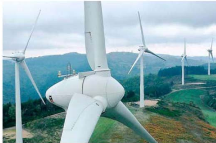
Le constructeur a quatre mois pour enlever les éoliennes sous peine d'une amende de 9 000 € par jour.
