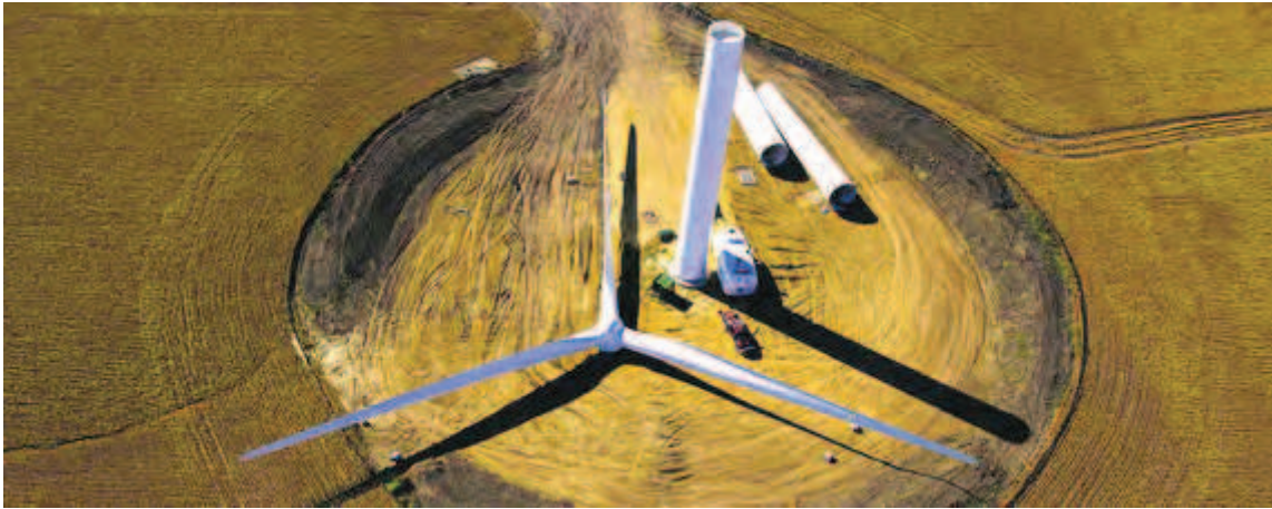
Bloomberg News - Una turbina de viento de Suzlon Energy Ltd. en construcción en Ohio, Illinois, EE.UU.
