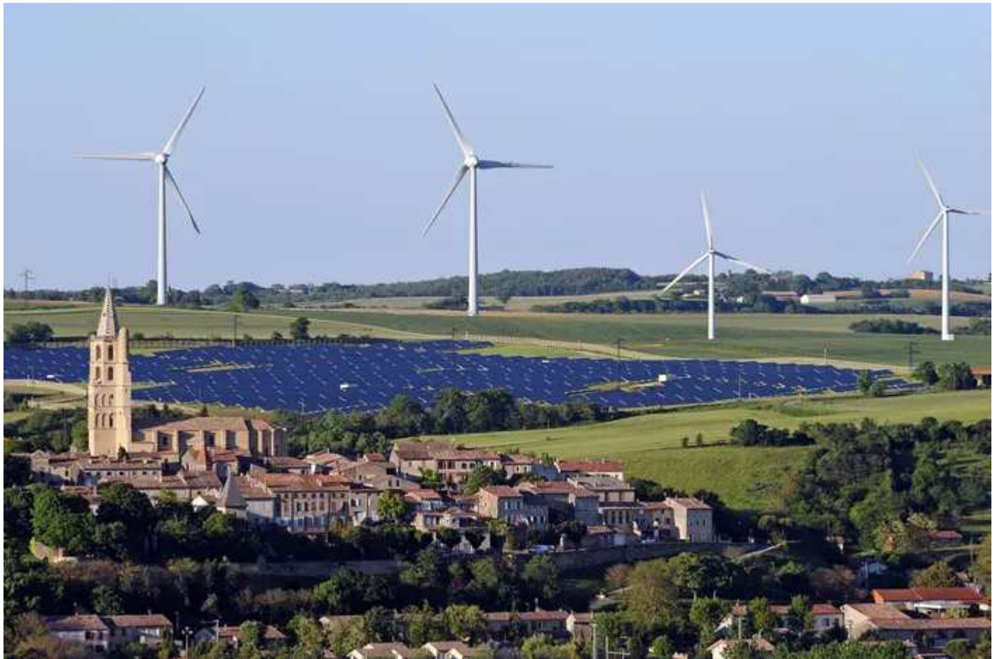
Le parc photovoltaïque et éolien d'Avignonet-Lauragais, au sud-est de Toulouse. REMY GABALDA / AFP
